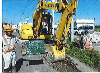
① 既設舗装版撤去
