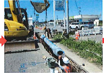
③ 水道管布設
