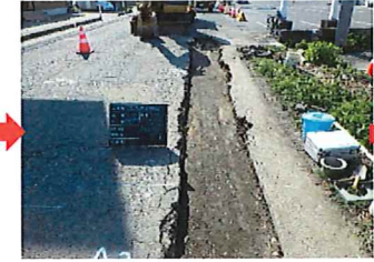
⑥ 下層路盤の施工
