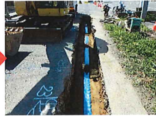
⑤ 埋設シート設置
