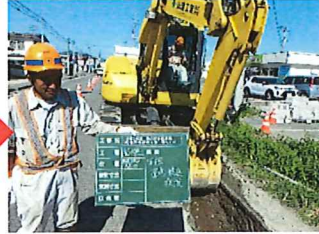
② 機械による掘削
